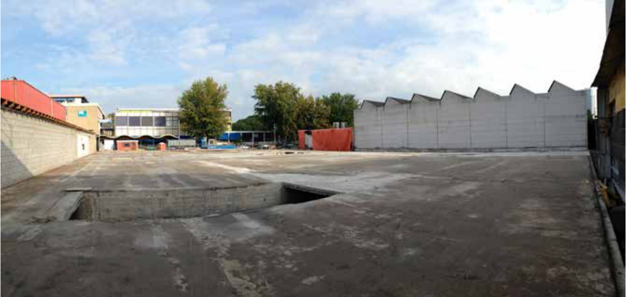
Het gesloopte pand in Utrecht
